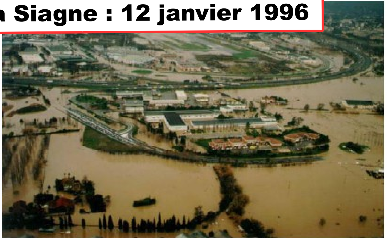
Inondation de 1996 – échangeur 41
